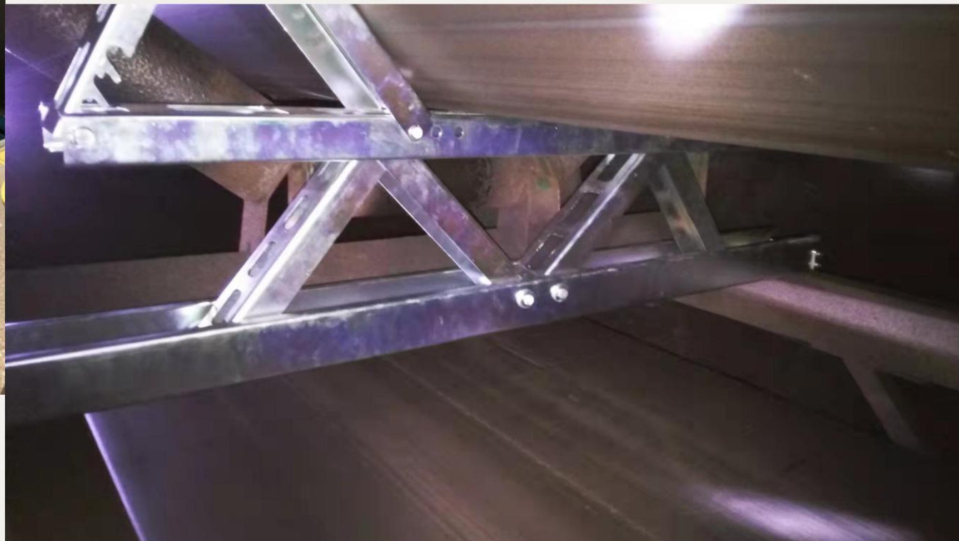
江西煤业尚庄煤矿主井筒皮带更换托辊
